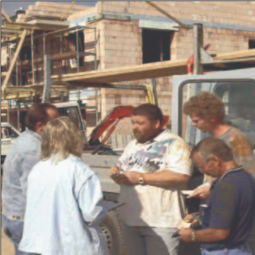
Baustellenkontrollen in Deutschland
